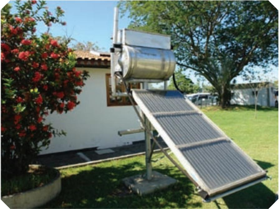
**Figura 2:** Sistema residencial de aquecimento de água por energia solar.
